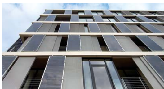
📷 Großflächige teiltransparente und opake Glasmodule eignen sich insbesondere für die Fassadenintegration. (Foto: Colt International)
